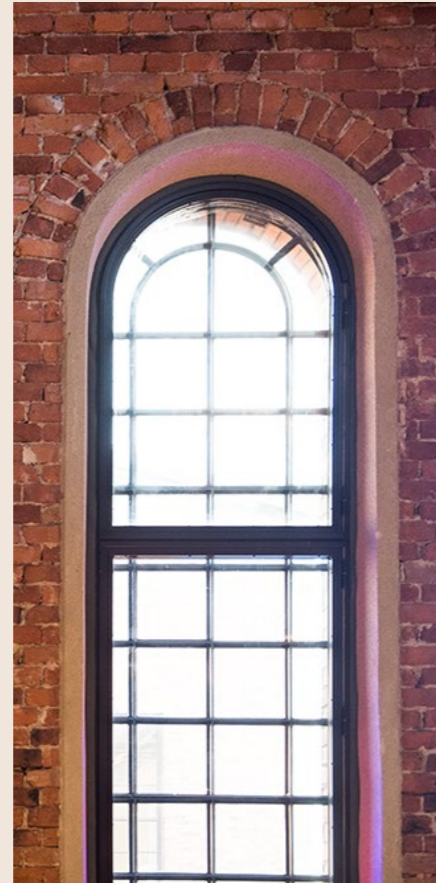
Referens fönster, Gasverket
